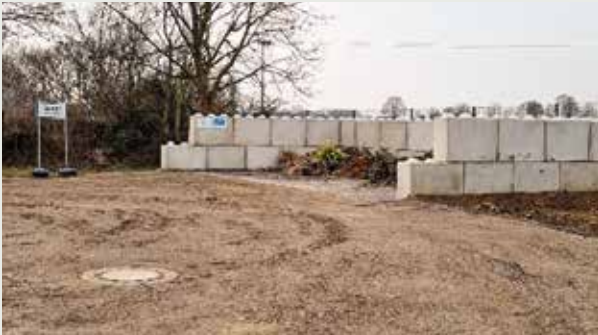
Grüngutschütte am Schnittgutlagerplatz
