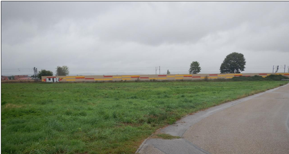
Abbildung 5: Lärmschutzwand an der Bahnlinie Obertraubling - Passau
