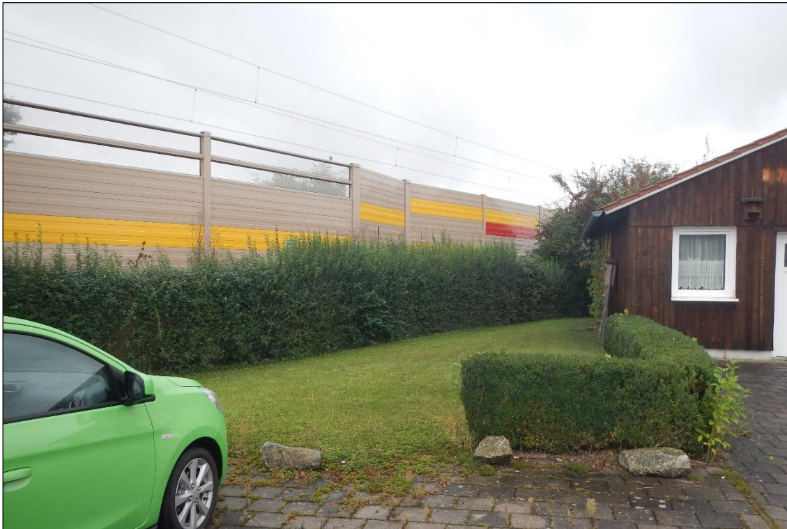
Abbildung 6: Lärmschutzwand an der Bahnlinie Regensburg - München
